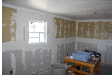
Drywall repairs
